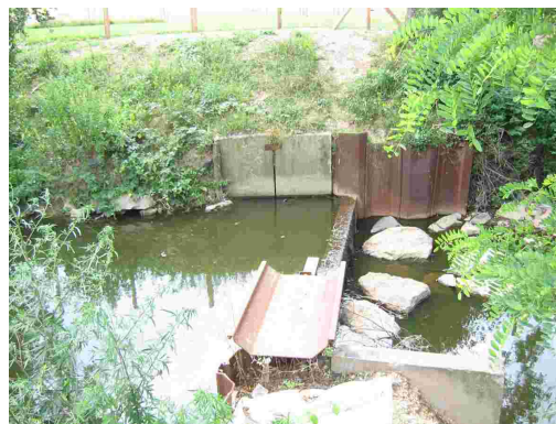
L'actuel seuil en palplanches
